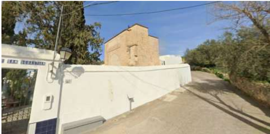
Figura 5. Acceso peatonal existente 5
